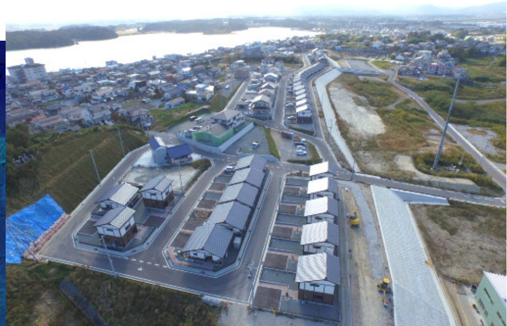
災害公営住宅 南ノ入団地
